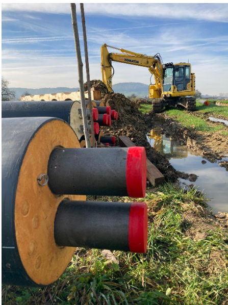
BU 2: Derzeit laufen die Bauarbeiten, um die Menschen in Bad Boll mit nachhaltig erzeugter Wärme zu versorgen.
