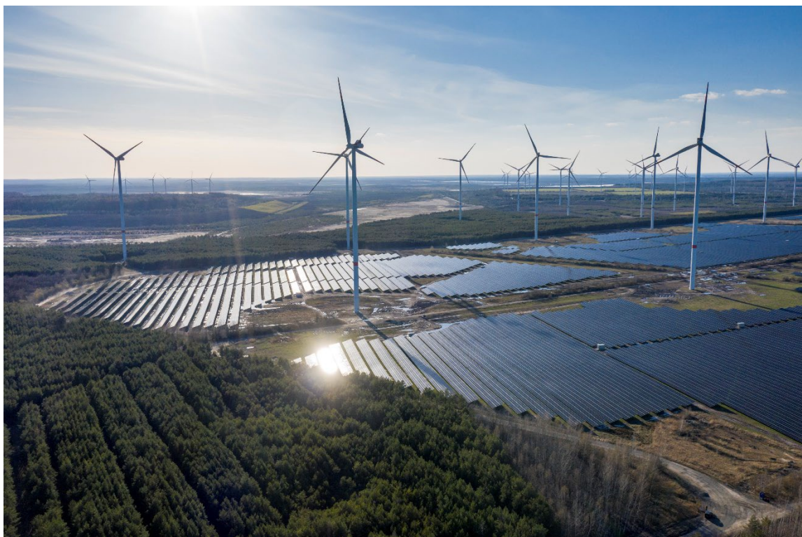
Der Energiepark Lausitz: Wind, PV und bald auch Wasserstoff. (Foto: GP JOULE)
