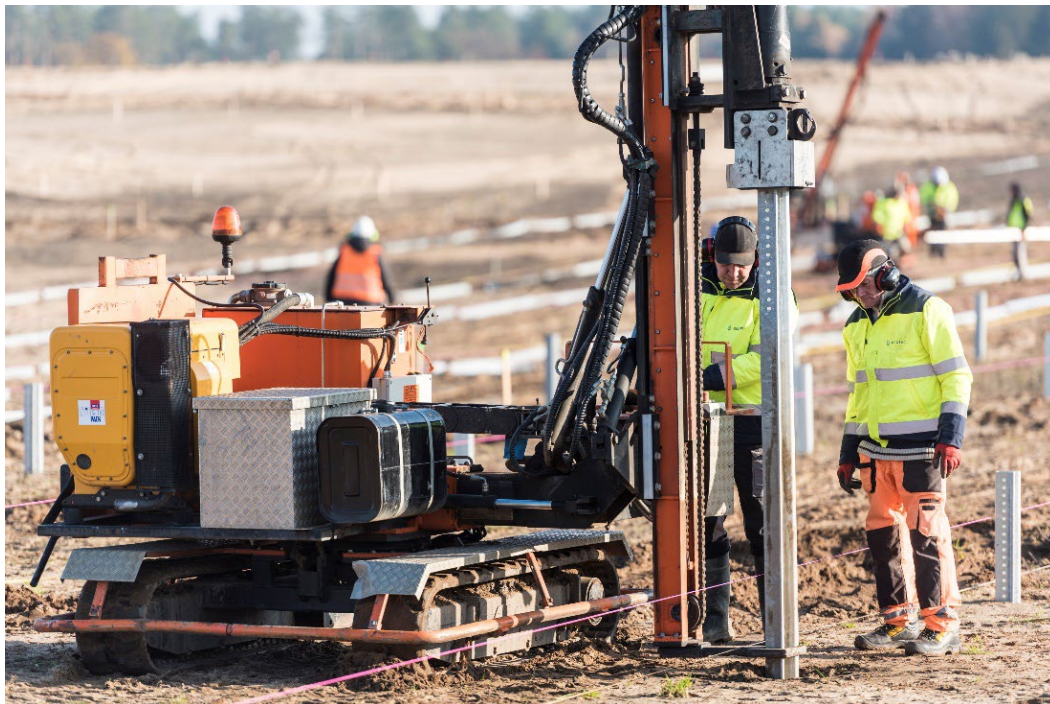
BU 2: Im Solarpark „Boitzenburger Land“ haben die Bauarbeiten begonnen. (Beispielbild aus dem Solarpark Ganzlin, Copyright: GP JOULE / Jörn Lehmann)
